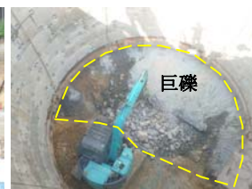
図-6 巨礫破碎掘削
