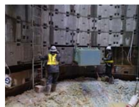
図-9 セグメント組立 (一般部)
