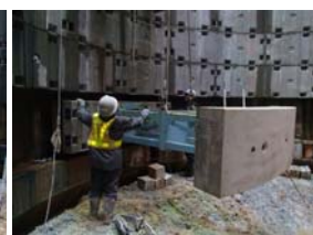
図-10 セグメント組立 (昇降設備下部)
