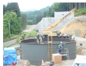
図-5 鋼製刃口組立
