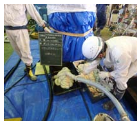
図-7 筒先ゲル化状況
