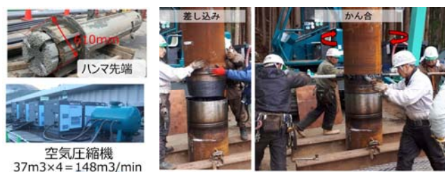
図-4 掘削機械と抑止杭継手
