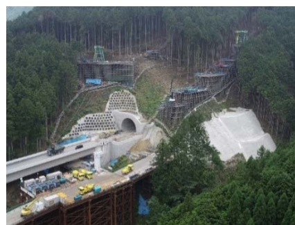
図-11 抑止杭施工状況全景
