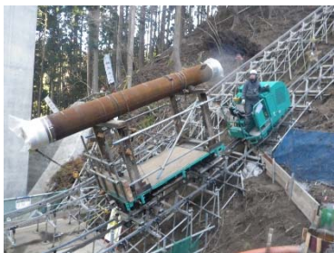
図-5 資機材運搬状況
