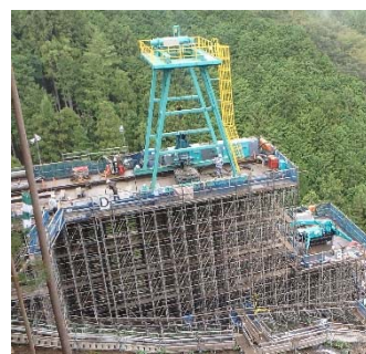
図-7 施工機械・仮設構台
