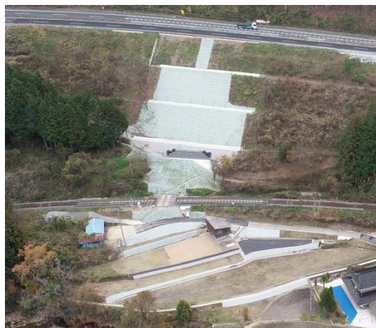
写真-3 恒久対策工完成状況
