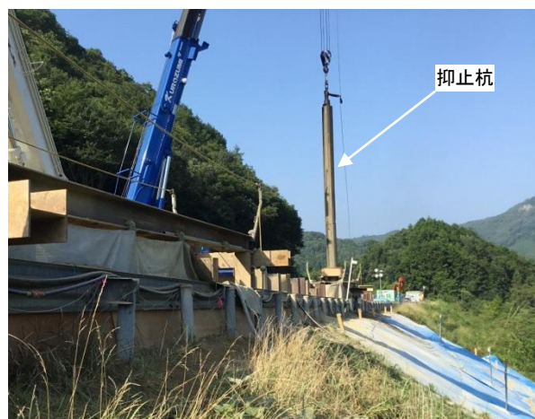
写真-2 抑止杭施工状況
