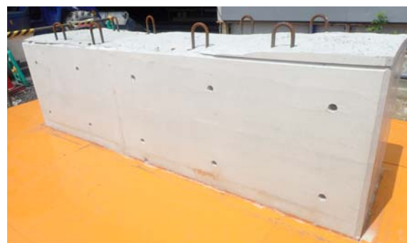
写真-3 脱型後の外観
