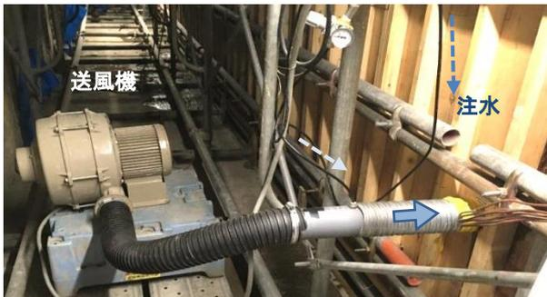
写真-1 クーリング機材配置(従来型)
