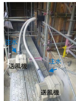
写真-2 施工状況
