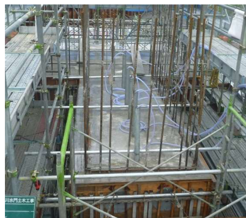
写真-1 パイプクーリングの状況
