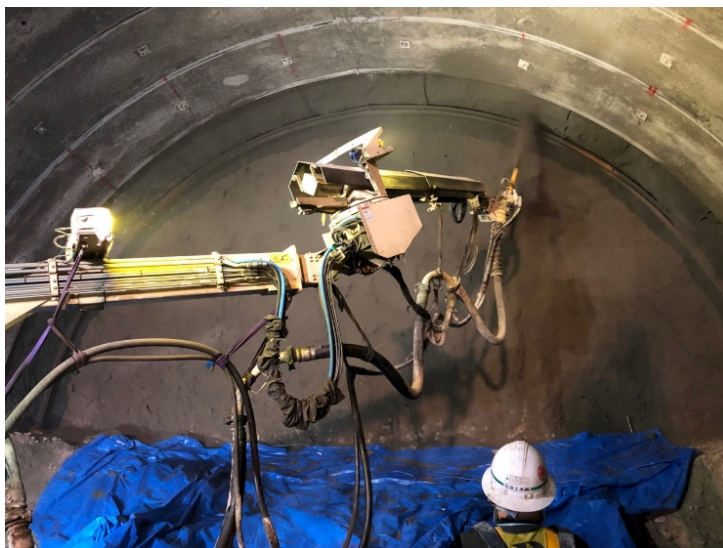
図-2 リバウンド率試験状況（天端部）
