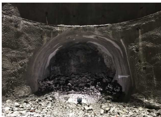
＜写真1 ロックラックによる破砕状況＞
