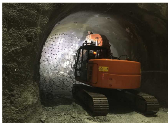
＜写真2 ブレーカーによる掘削状況＞
