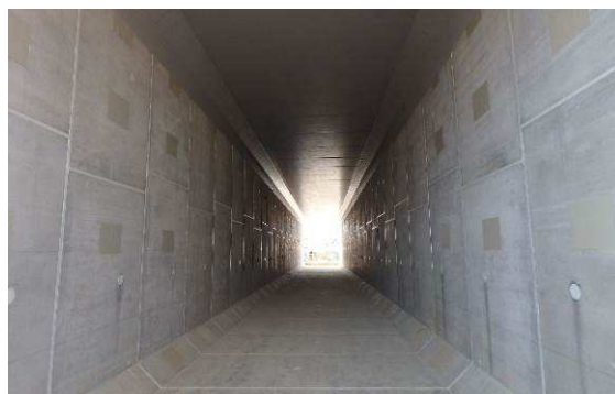
写真-2 施工完了状況
