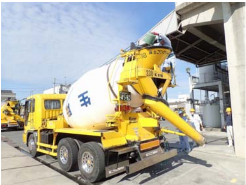
写真-1 硬化促進剤添加状況
