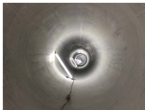
写真-2 二次覆工脱型後全景
