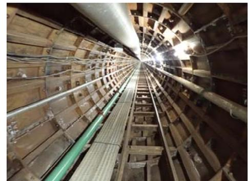
写真-1 長距離圧送配管状況
