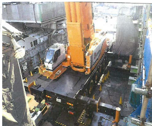
写真-1 550t クレーン組立状況
