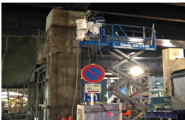
写真-3 P3 橋脚コア施工状況写真
