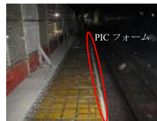
写真-2 埋設型枠（PIC フォーム）施工状況
