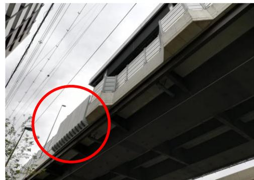
写真-2 FRP 壁高欄設置状況
