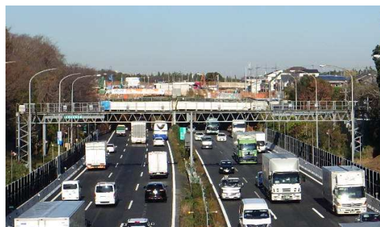
写真－1 大和トンネルの拡幅前の状況
