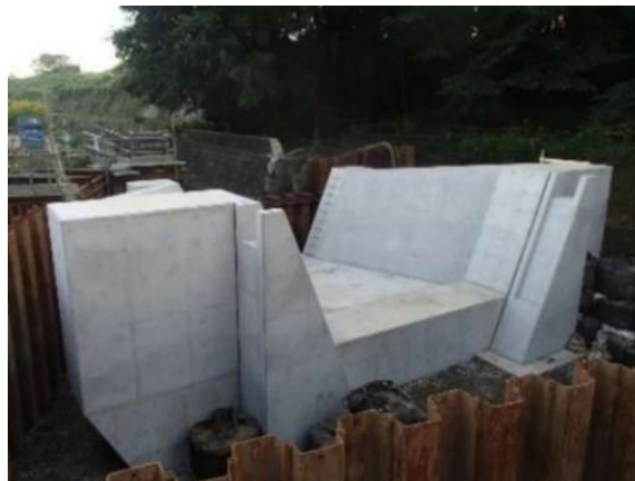
写真-2 床固工完成写真
