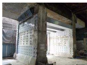
写真-1 施工写真
