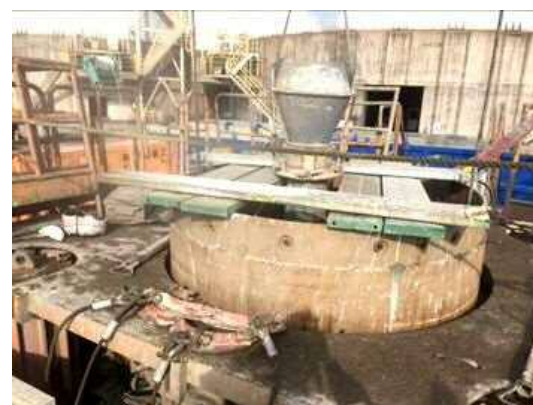
写真3 生コン打設状況
