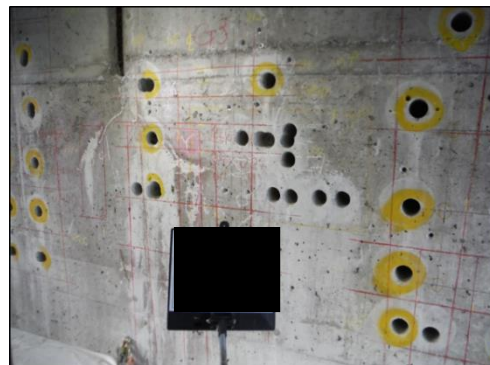
写真1 コア削孔の現場例
