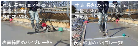
写真-2 表面締固めバイブレータの使用状況
