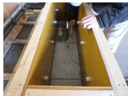
写真-1 エポキシ樹脂系接着剤の塗布状況
