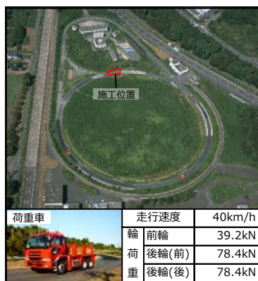
写真-1 舗装走行実験場
