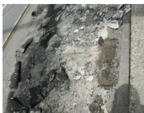
写真-4 防水材を剥 ぎ取っている状況
