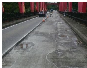
写真-7 舗装を剥ぎ取った後の床板表面
