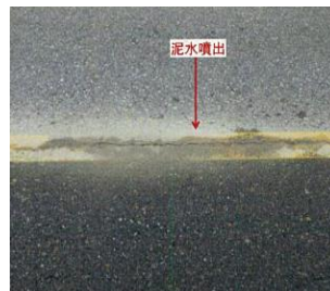
写真-3 舗装打継ぎ目 から噴出した泥水
