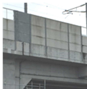
写真-1 桁跨ぎ防音壁
