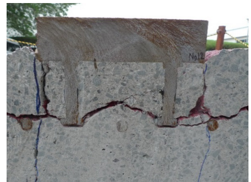
(b) 試験体 C1-R (補修有り)
