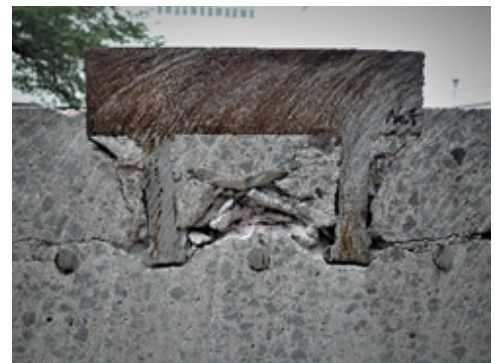
(a) 試験体 C0 (ひび割れ無し)
