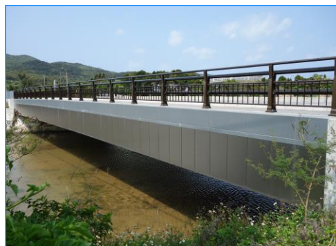
写真-1 調査橋梁全景
