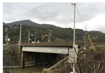
写真-1 橋りょう全景
