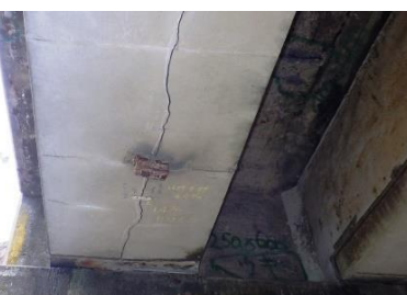
写真-2 桁表面の状況
