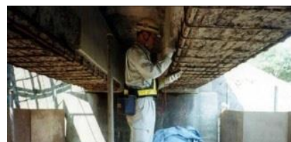
写真-3 施工時のはつり状況
