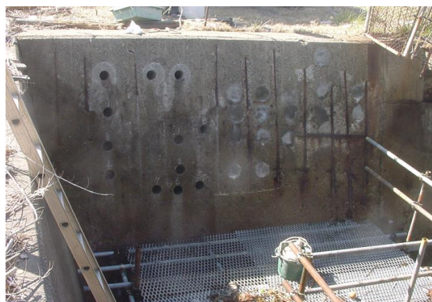
図4 沿岸部通路橋側壁
