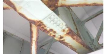
図-1 発錆した鋼構造物
