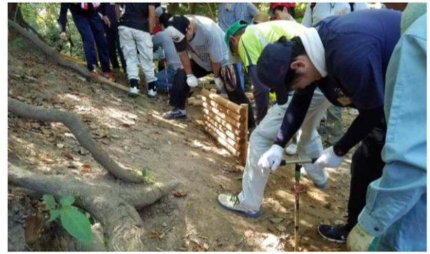
写真-2 杭の打ち込みの様子
