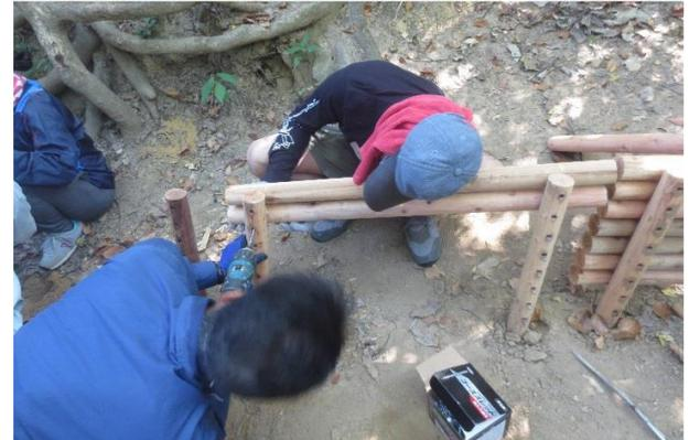
写真-3 柵材取り付けの様子
