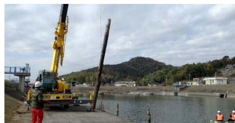
写真-1 丸太回収状況
