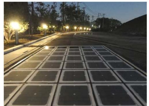
写真-1 太陽光発電舗装と夜間点灯(独立電源)
