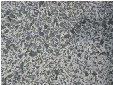
写真-2 施工前表面
