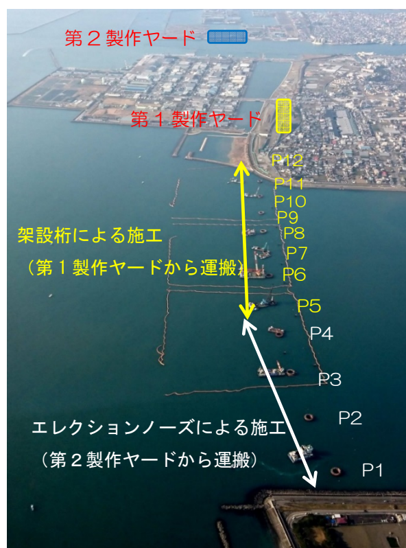
写真-1 工事全体写真
