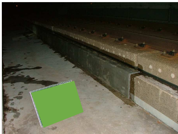
図-6 補修後状況写真
