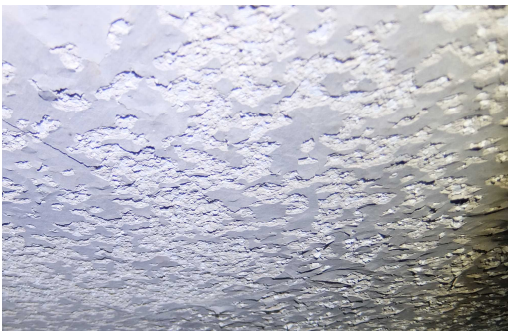
写真-1 ポップアウト部の状況
