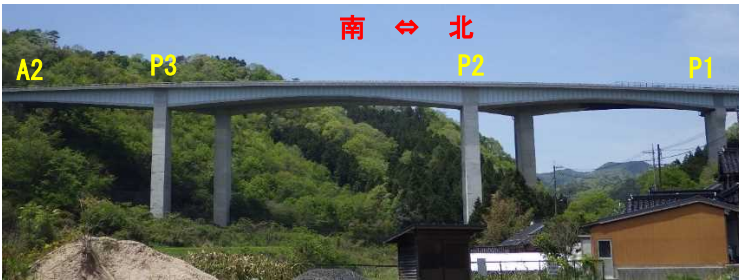
写真-1 橋梁全景
