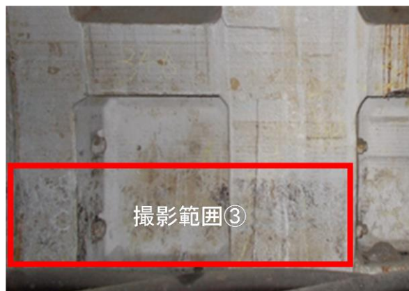
写真-1 トンネル壁面の状況
