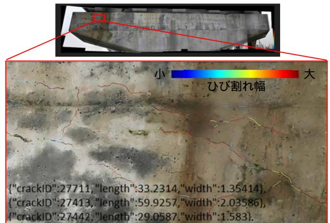
図-3 ひび割れ幅および長さ算出の例
