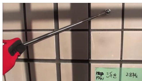
図2 95mm 角のタイルの打音検査
