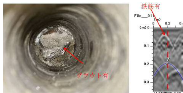
写真-2 調査結果と電磁波レーダー図 (B)
