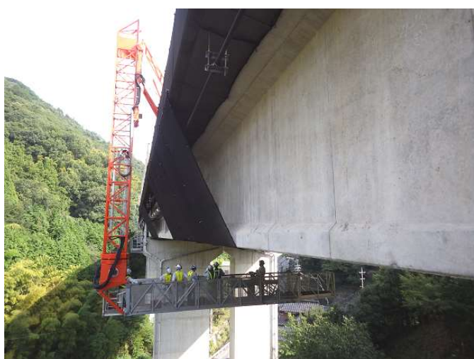
写真-3 大型の橋梁点検車
