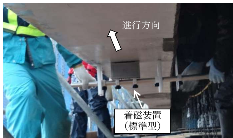
写真-1 T桁下面側からの着磁状況
