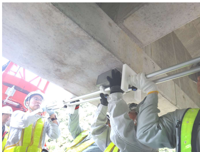
写真-4 点検車走行による橋軸方向の着磁状況
