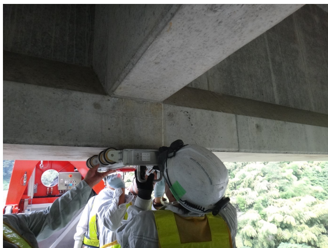
写真-5 点検車走行による磁束密度測定状況
