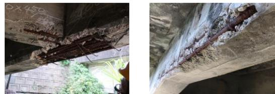
写真5 主桁の鉄筋剥離部
