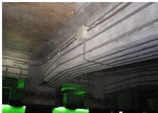
写真-2 電気防食の適用状況（9年後）
