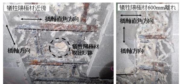
写真2 断面修復とコンクリート境界の鉄筋状況
