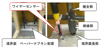
写真-1 境界面近傍の状況(側壁コンクリート打設前)
