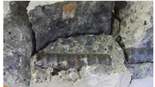
写真-2 鉄筋の腐食状況
