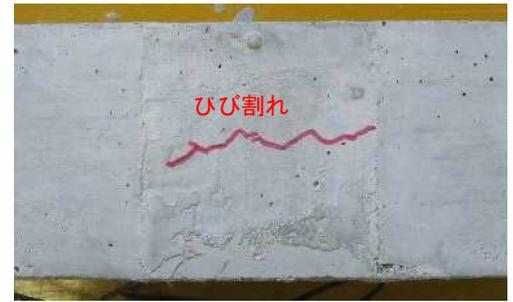
写真-1 ひび割れ発生状況
