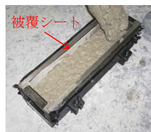
図 1 試験体製作状況
