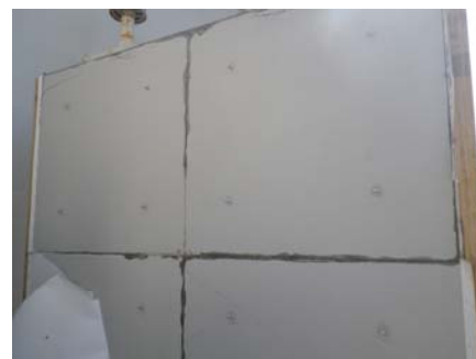
図7 脱型後の状況
